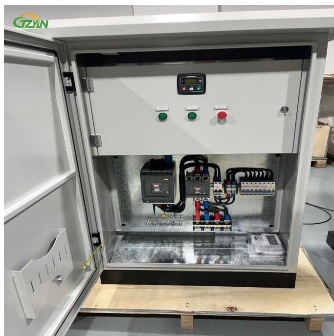
ภาพประกอบที่ 1.1-4: เครื่องกำเนิดไฟฟ้าสำรองพร้อมตู้สวิตช์ถ่ายโอนอัตโนมัติ (ATS)
